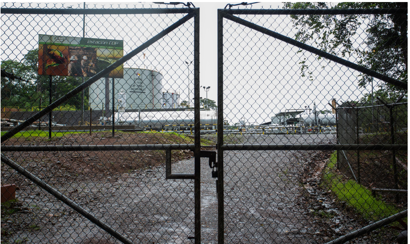
Instalaciones de la empresa PetroOriental en el Bloque 14.. Foto: Ivan Castaneira/Acción Ecológica
