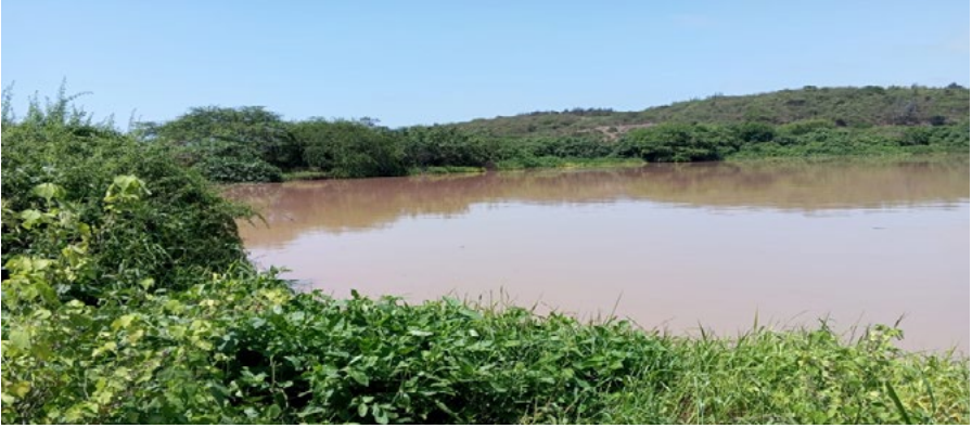
Primera Laguna de Oxidación / Laguna Anaerobia
