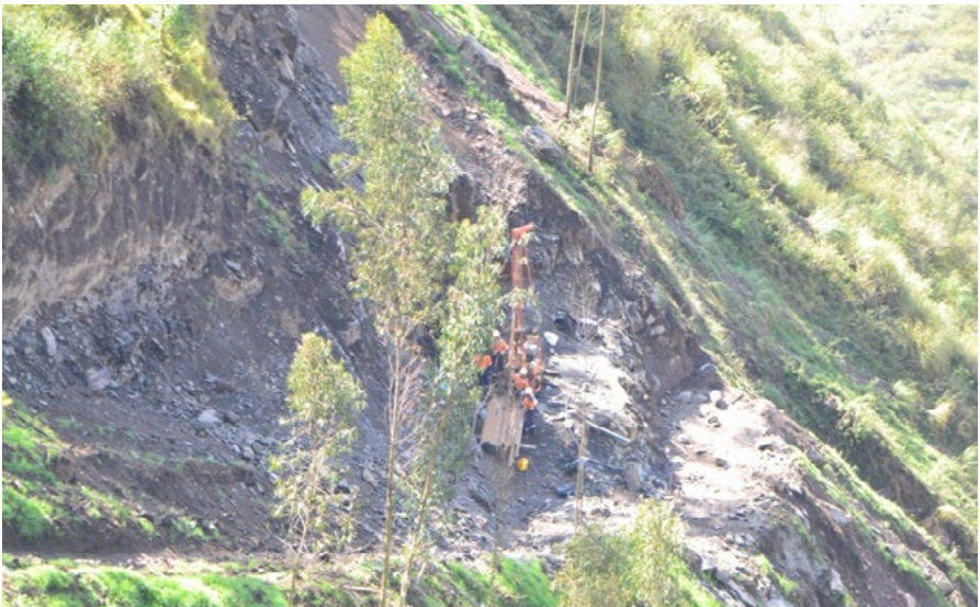
Quebrada El Batán y los trabajos de la empresa CRBC Foto: Cinthia Andrade
