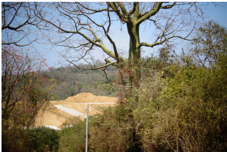
Avance de las obras de la cárcel
