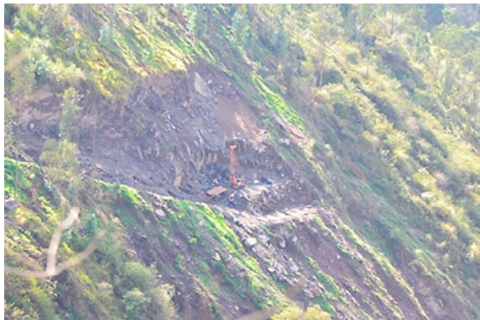
Empresa CRBC trabajando en la quebrada El Batán
