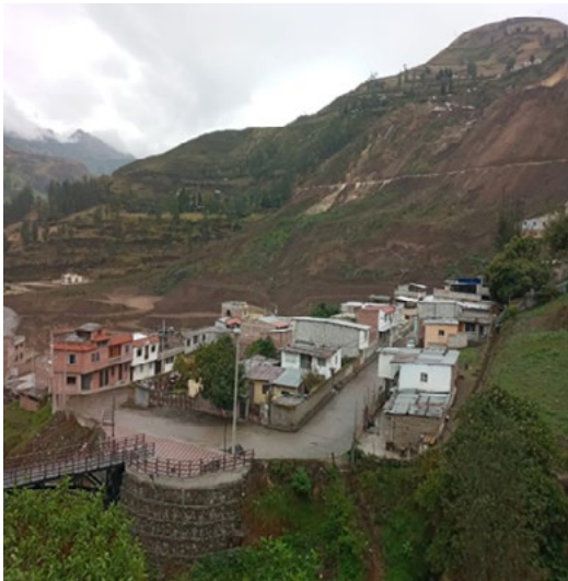
Zona afectada Foto: Rosa Pacari
