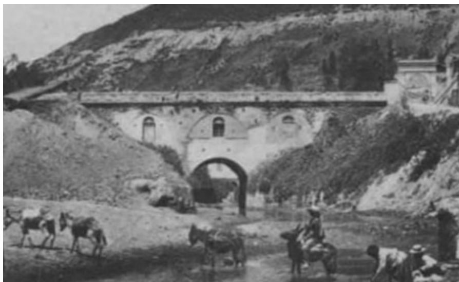
Puente sobre el río Machángara Foto de archivo
