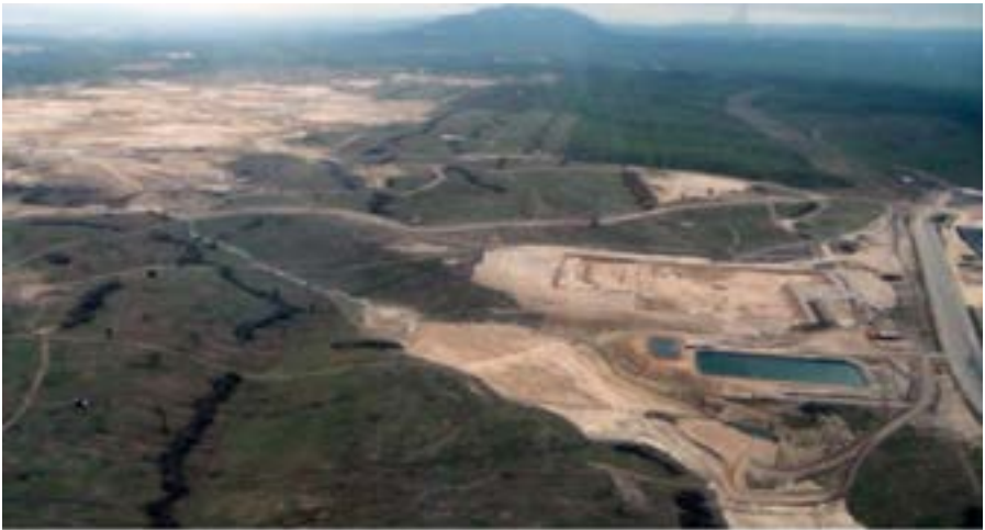
Preparación del terreno para la construcción de la planta industrial. Al fondo el Cerro de Montecristi.
