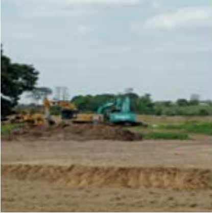
Maquinarias que están realizando trabajos
