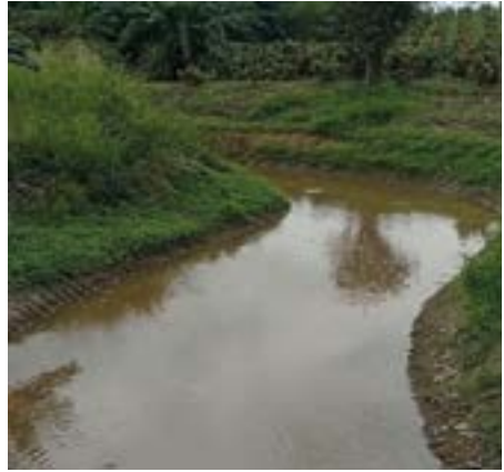
Canal de drenaje para evacuar el agua del humedal Las Garzas
